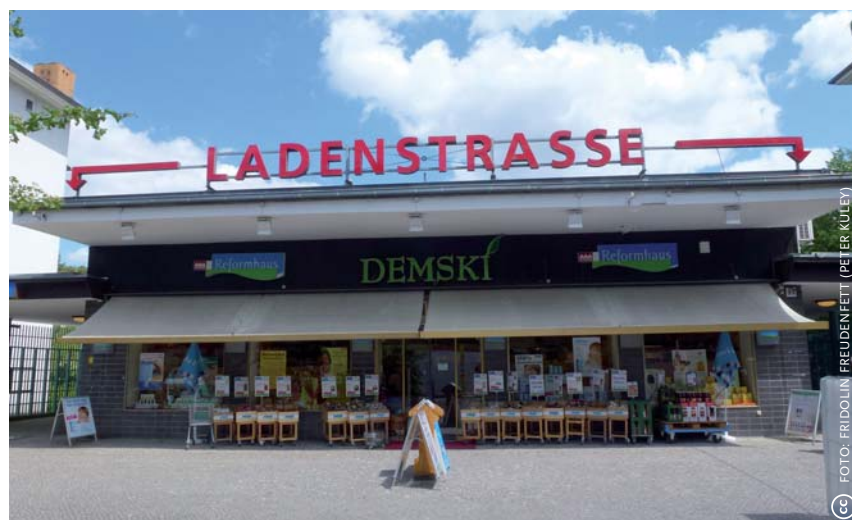
Het metrostation Onkel Toms Hütte ligt in een overdekte goot en heeft een eilandperron. In het dak zit een glazen koepel, waardoor er daglicht op het perron valt. Parallel aan de sporen zijn winkelpassages ( Ladenstraßen ) aangelegd.
